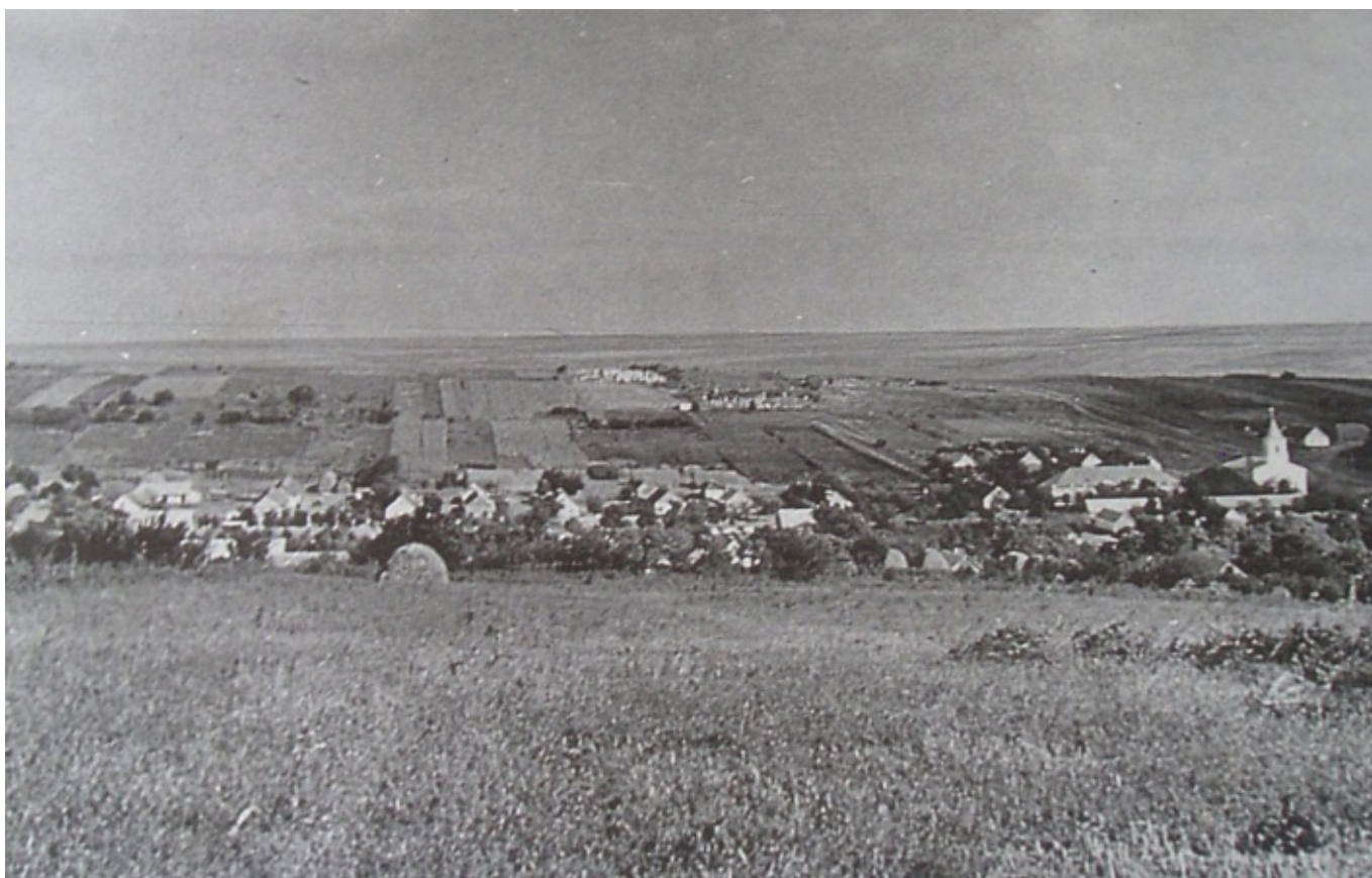
Teilansicht von Hoffnungstal 1940, aufgenommen von West nach Ost. Sehr gut zu erkennen ist die Kirche, links daneben das langgestreckte Schulgebäude. In der Bildmitte, hinter dem Dorf liegt der Friedhof. Weiter hinten verliert sich dann der Blick in der weiten Steppe.
